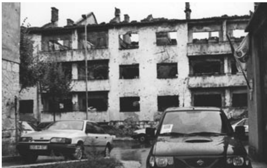
Måga Bosnier som tjänat pengar i Väst kommer hem och bygger nytt. Men det finns också många övergivna och krigsskadade hus som tillhör personer som blivit offer för kriget. Som det här huset i Mostar.
